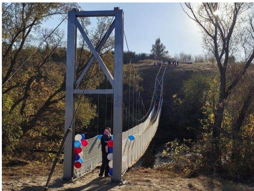
Рисунок 1 – Подвесной мост в деревне Володаровка
