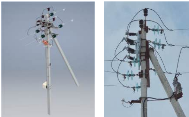
Рис. 1. Примеры установки РМИ 6-10 кВ
