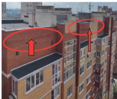
Рис. 1. Замачивание кирпичной кладки
